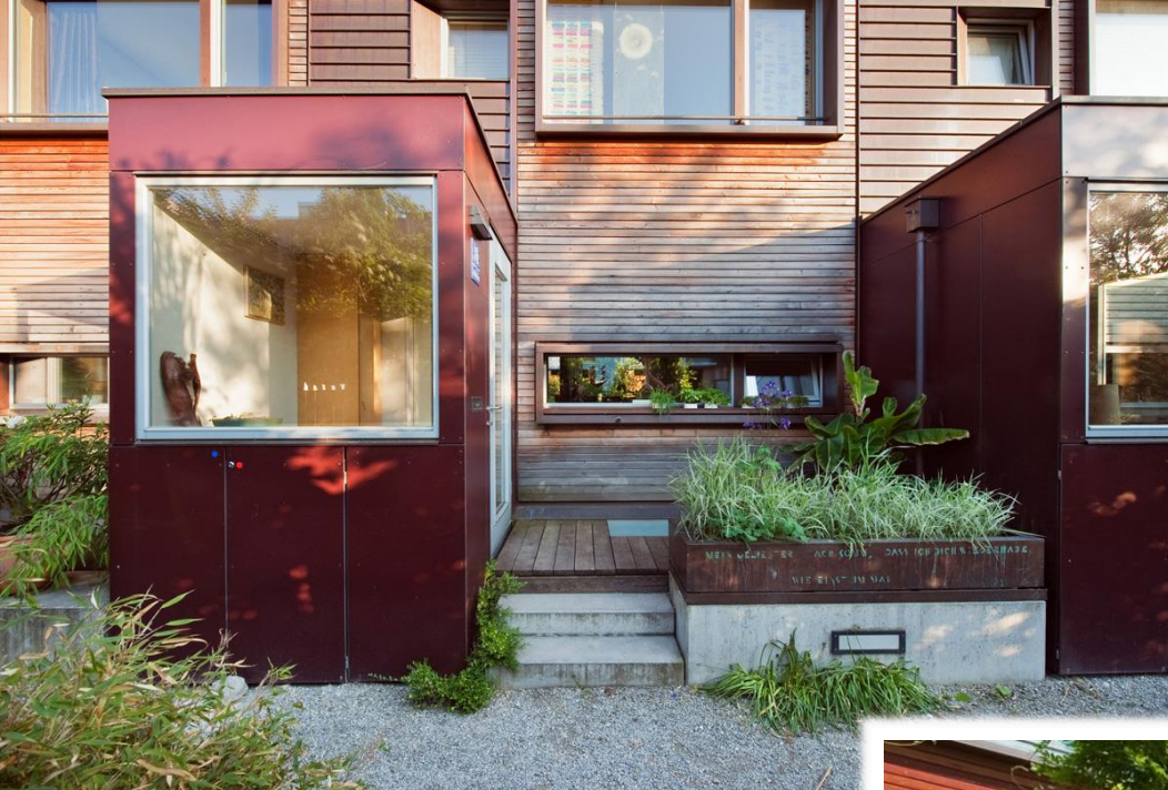
Abb.15: Eingangssituation © Baugemeinschaft „Stadtgestalten Schwabing“
