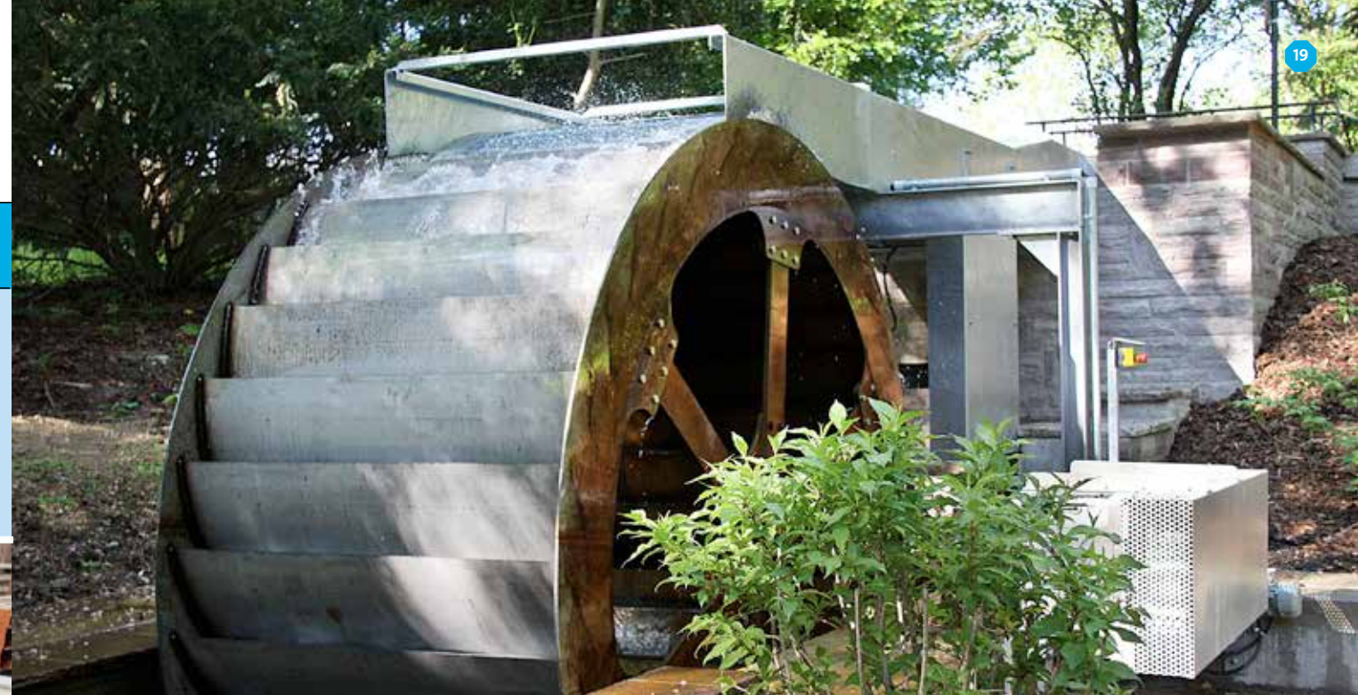
↑ | Die Wasserkraftanlage in Gronespring
