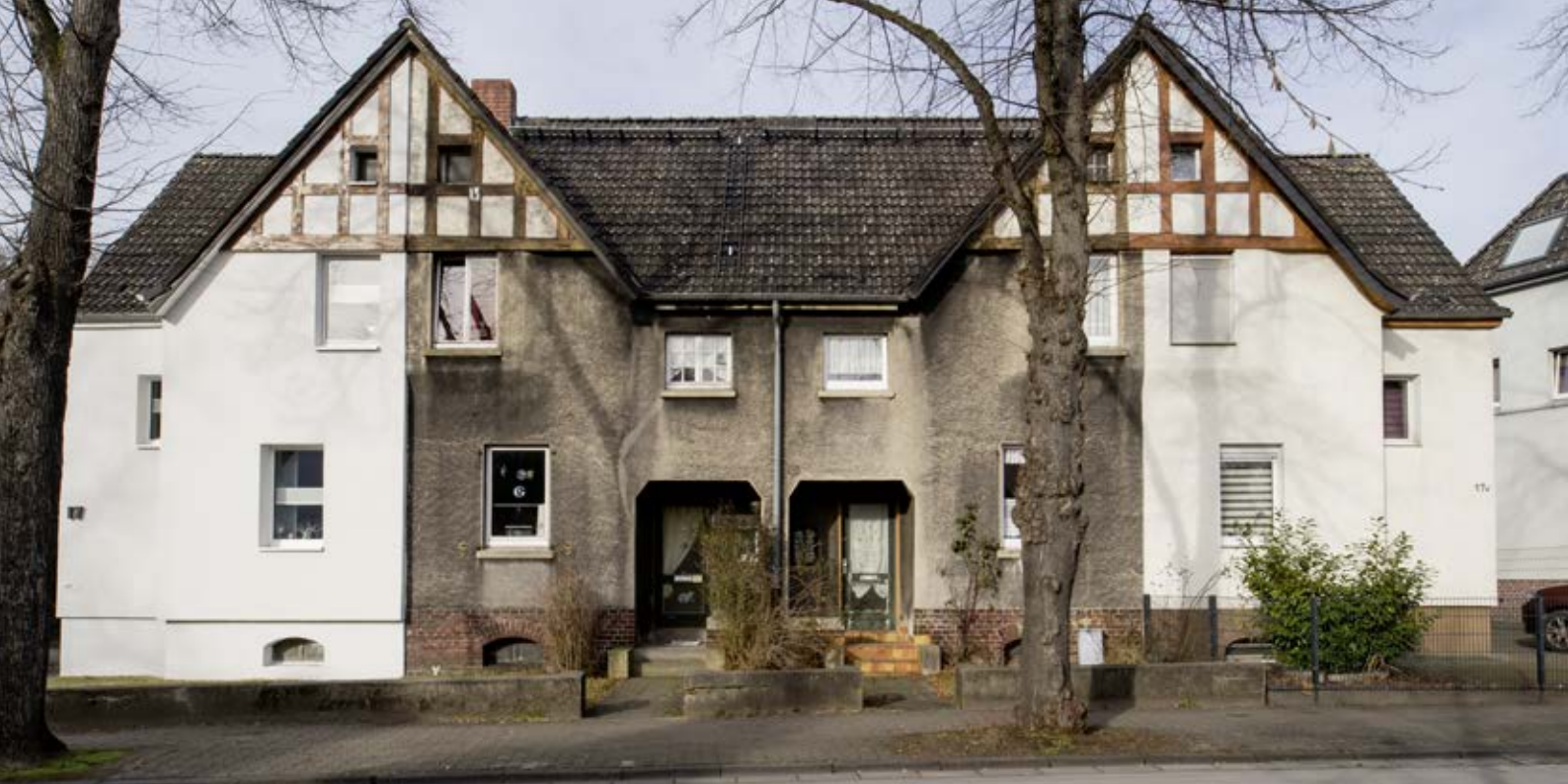
Teilsaniertes Zechenhaus im Energielabor Ruhr
