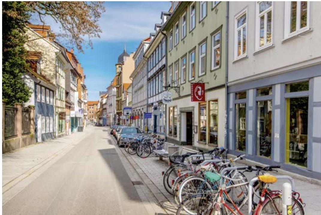
Sanierte Fachwerkgebäude in der Burgstraße
