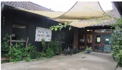
Abbildung 35: Eingangsbereich des AWO-Häuschens
