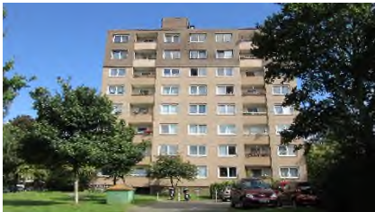
Abbildung 5: Punkthaus Am Steinsgraben
