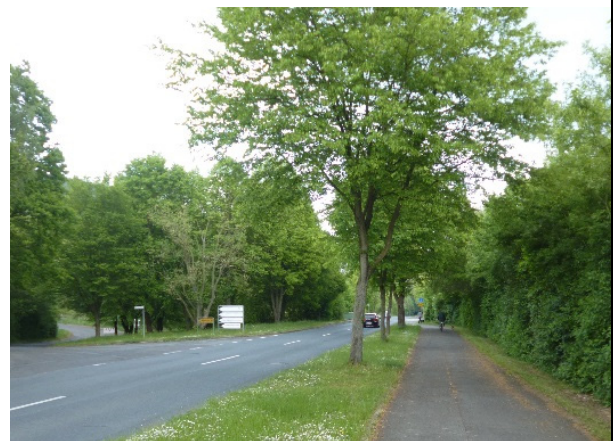
(46) Abzweig Deppoldshausen – fehlender Durchlass Quelle: eigenes Foto
