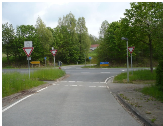
(45) hier: B27 / Hohler Graben - Sichteinschränkung durch Grünbewuchs Quelle: eigenes Foto
