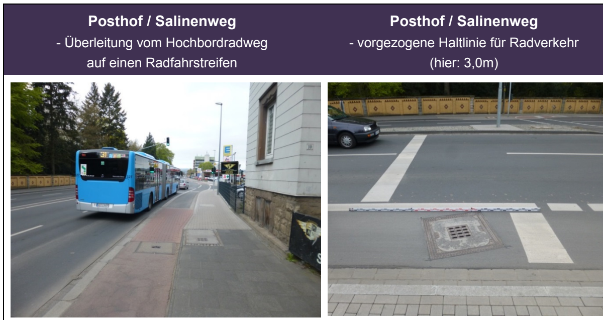
Abbildung 19: Musterlösung der Radverkehrsführung an LSA-Knotenpunkt
