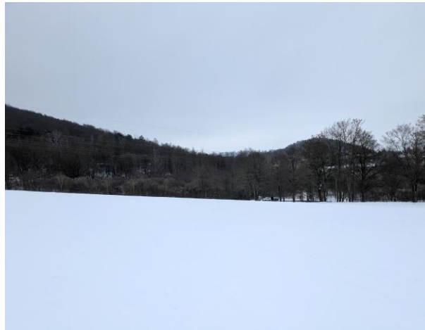
Foto 1: Blick auf das Baufeld in Richtung Südosten: Die Erkundungsarbeiten wurden mit einer ferngesteuerten Sondierdraupe Typ "ARGOS" durchgeführt. Der hydraulische Hammer bringt 111 Joule auf die Sonden.
