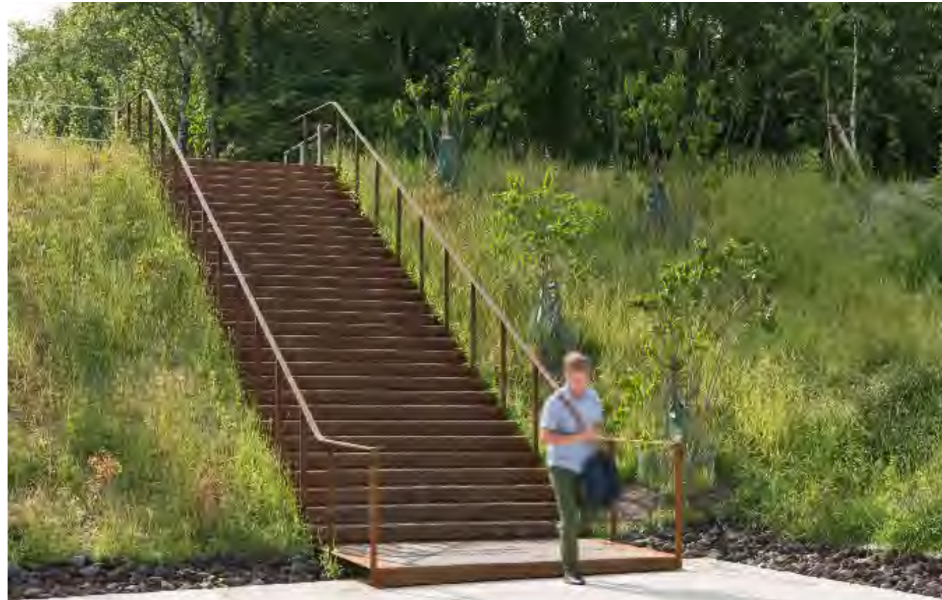
Cortenstahl Treppe, Park Gleisdreieck, Berlin Atelier Loidl Abb. 14
