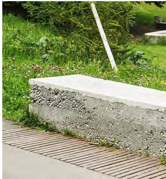
Stampfbeton Mauern, Terrassierung Abb. 33
