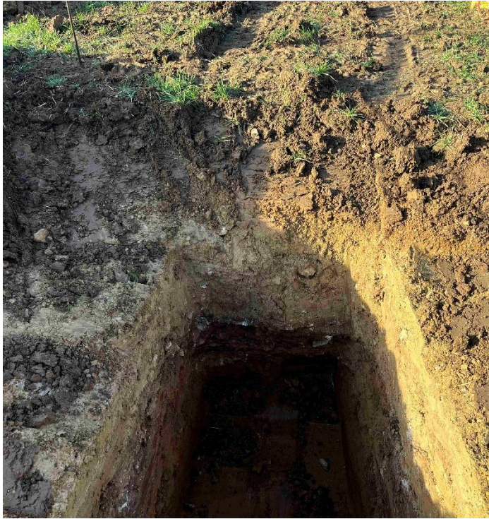
Abbildung 7: Schürfgrube S4, Ansicht Schürfgrube (Foto: WGK GmbH 2025)
