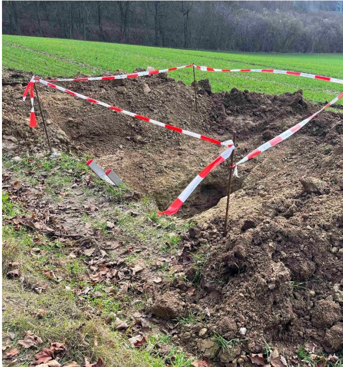
Abbildung 3: Schürfgrube S5, Ansicht Schürfgrube (Foto: WGK GmbH 2025)
