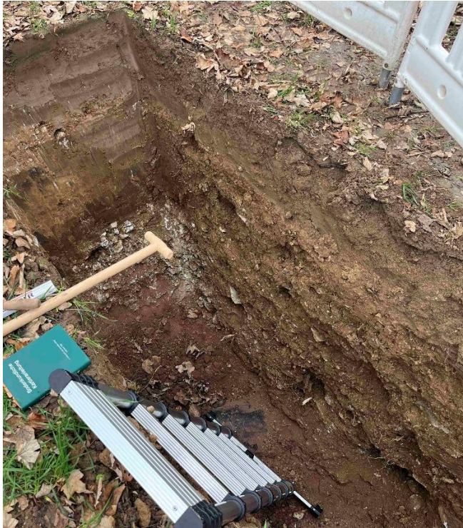
Abbildung 1: Schürfgrube S4, Ansicht Schürfgrube (Foto: WGK GmbH 2025)
