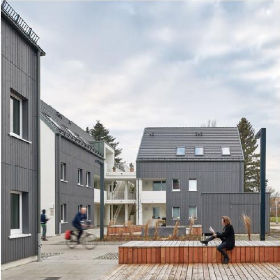
Hofsituation zwischen den Gebäuden
