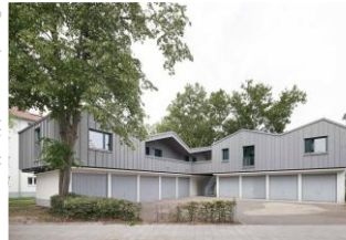
Aufstockung Garagenhof Karlsruhe
