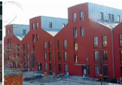
Neue Wohngebäude auf Konversionsflächen im Bereich Lohberg
