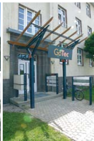
Nachnutzung eines ehemaligen Kasernengebäudes als Technologie- und Gründerzentrum
