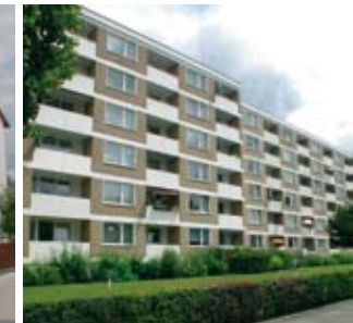
Geschosswohnungsbau in Grone-Süd
