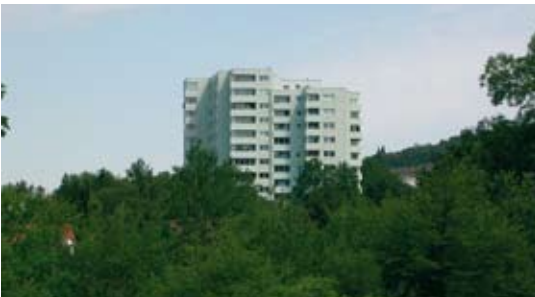
Geschosswohnungsbau in Geismar
