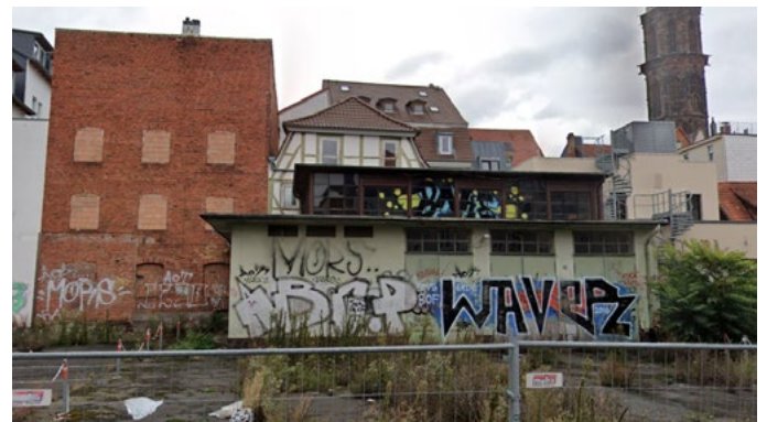
Das Gleichrichterhaus Stumpfbiel 17 vor dem Abriss im Oktober 2025. Foto von H. Rappe.
