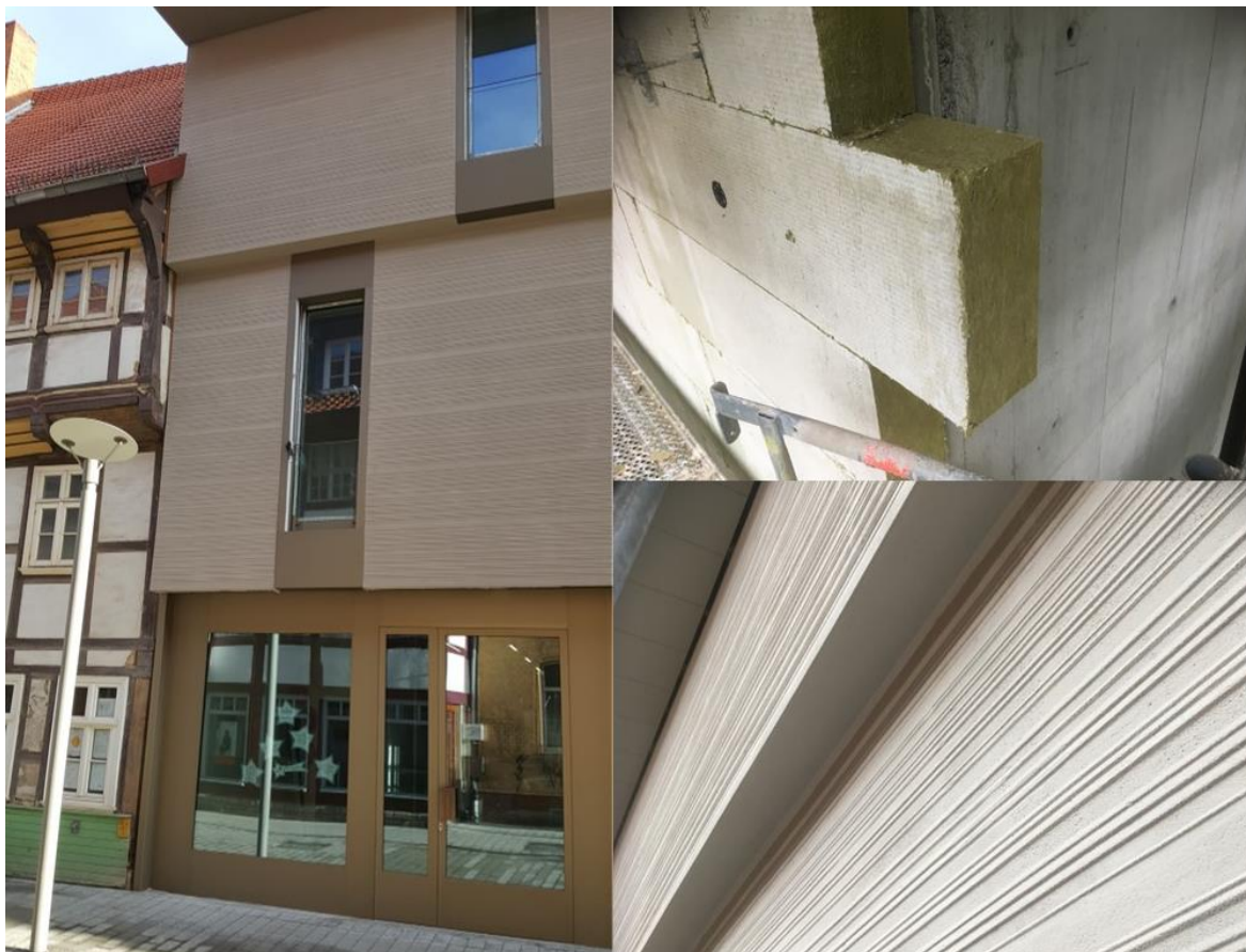
Abbildung 2: gekämmter, mineralischer Modellierputz (Quelle: Stadt Göttingen Fachbereich Gebäude)
