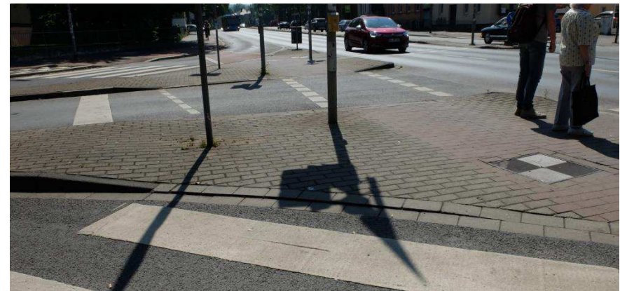
Abbildung 15: abgesenkter Bordstein (3cm) an der Bürgerstraße (inkl. Nullabsenkung für den Radverkehr)
