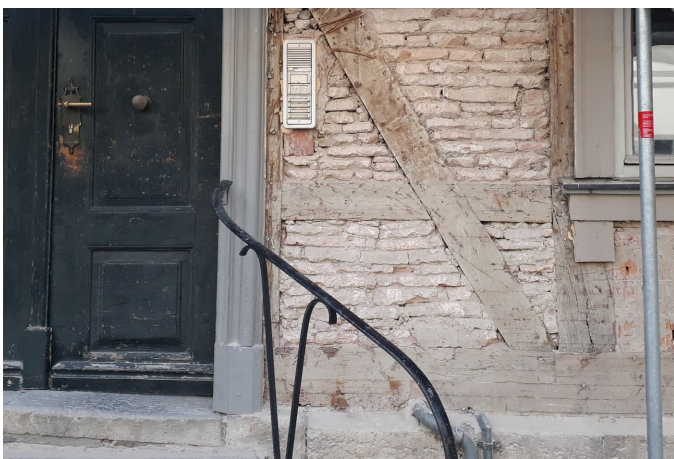
Abb. 3: freigelegte Gefache am Dürerhaus mit recycelten Estrichplatten, 2025
