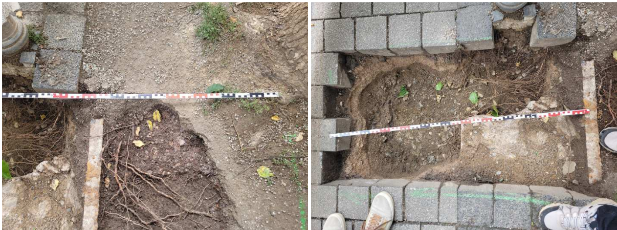
Abb. 6: Blick auf die freigelegte Baumscheibe der Baumhasel 1760 mit stammnah eingebauten Stahlträgern und Betonkonstruktionen (Fotos REHM)
