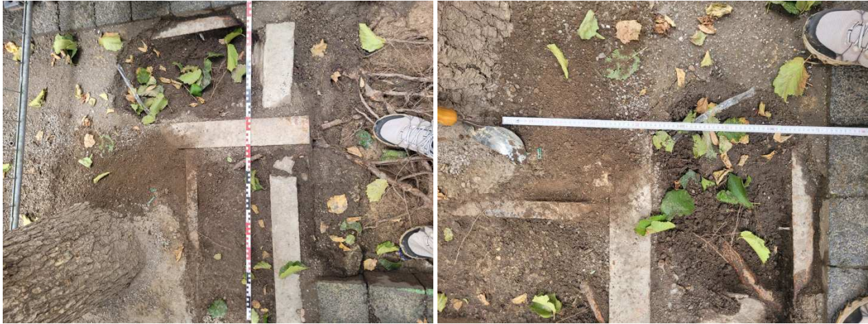
Abb.5: Blick auf die freigelegte Baumscheibe der Baumhasel 1758 mit stammnah eingebauten Stahlträgern und Betonkonstruktionen (Fotos REHM)
