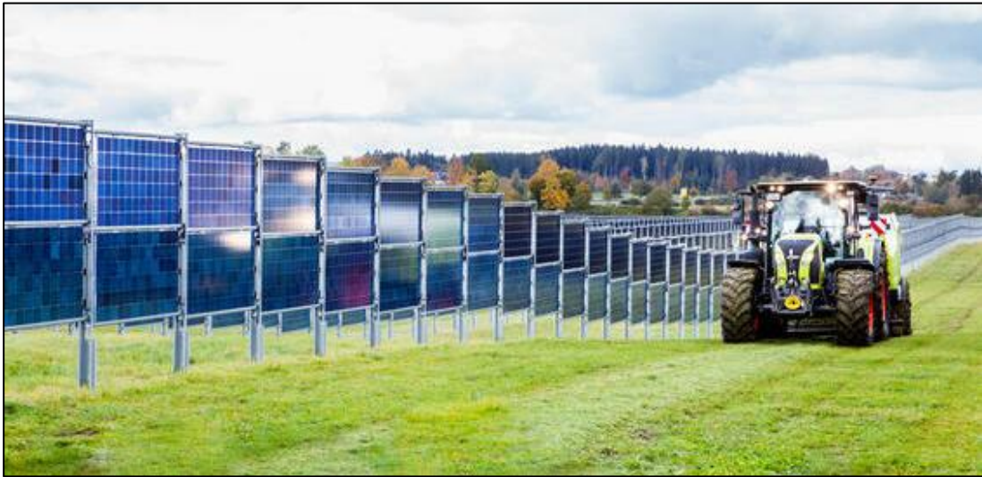
Abbildung 5 Beispiel einer Agri-PVA mit vertikaler Zaunanlage (© next2sun)
