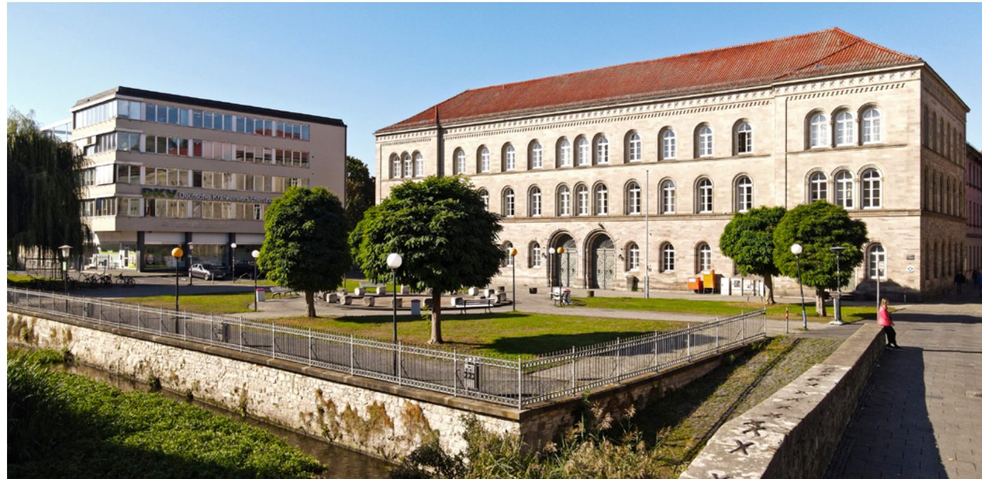
Blick auf den Waageplatz von der Brücke Reitstallstraße, © Stadt Göttingen/ Christoph Mischke
