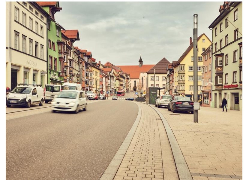
Hochbrücktorstraße Rottweil – vorher und nachher
