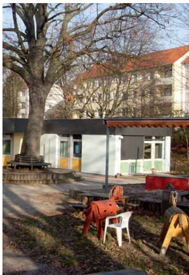
Bild: Kita Lönsweg energetisch saniert
